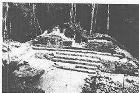
Fachada sur del edificio A-7
